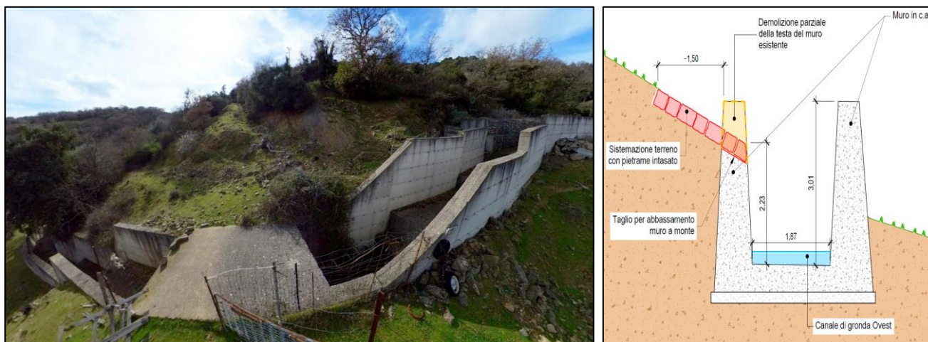
Figura 26 – Canale di gronda ovest con muri di sponda lato versante più alti del versante
