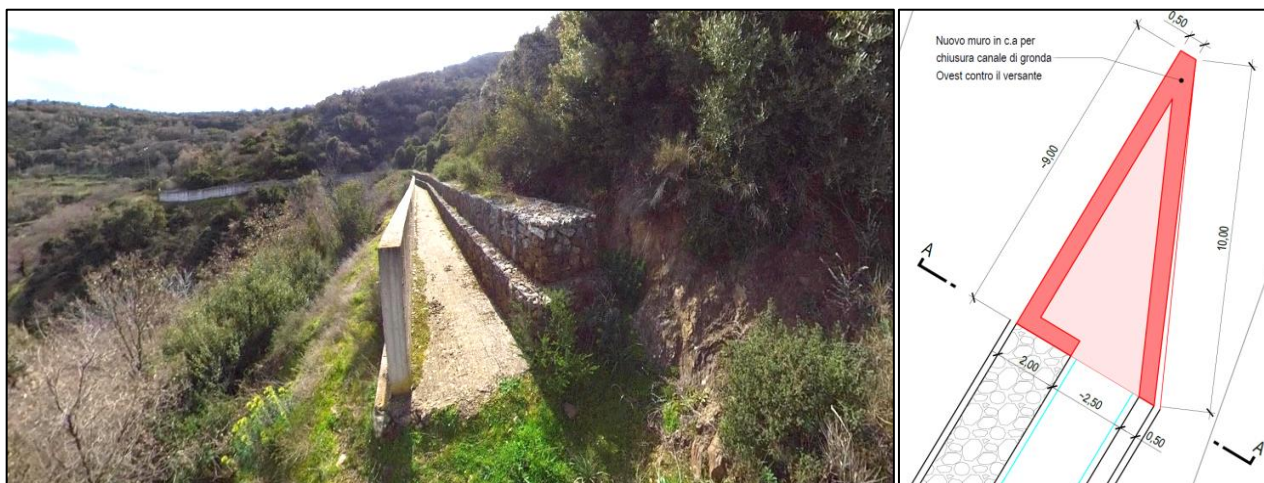
Figura 27 – Imboccatura di monte canale di gronda ovest (stato di fatto e intervento di progetto)
