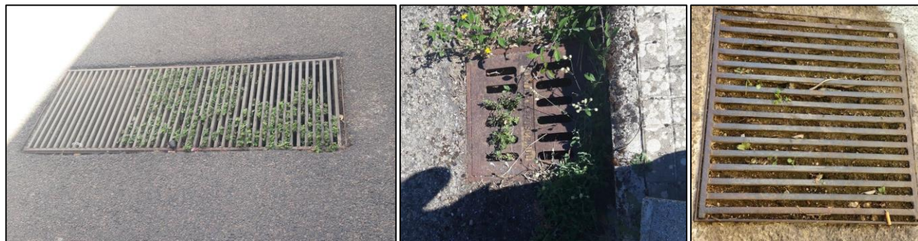
Figura 45 – Esempio di caditoie ostruite
