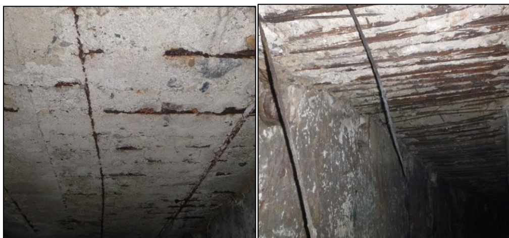
Figura 44 – Esempio di ammaloramenti sui lati interni del canale
