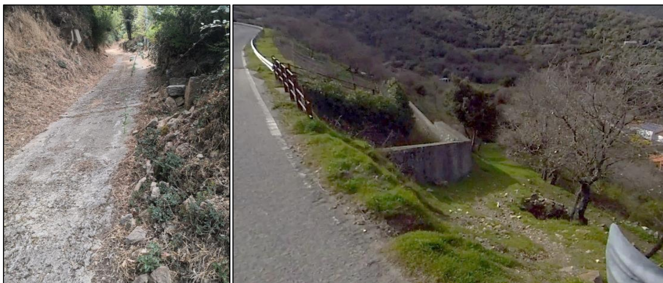
Figura 29 – Strade canale con segni di erosione ai piedi del versante
